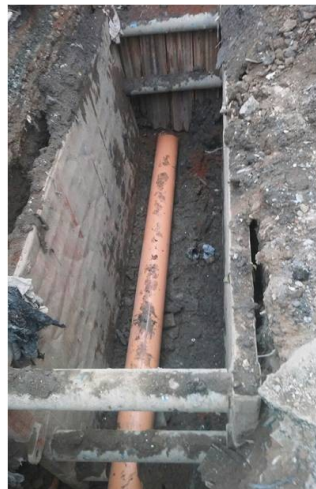
Serviço de prolongamento – Esgoto (Foto—10/2016)
