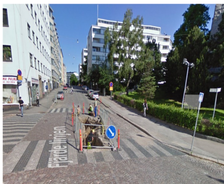
Sinalização de obras em Helsinque—Finlândia (Foto—02/2017)
