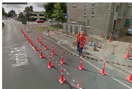
Sinalização de obras em Hamilton—Nova Zelândia (Foto—02/2017)
