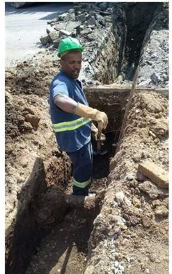
Cleverton Evaristo dos Santos, durante execução de serviços em vias públicas.
